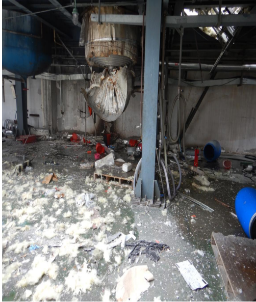
17#釜下部（车间一楼）
